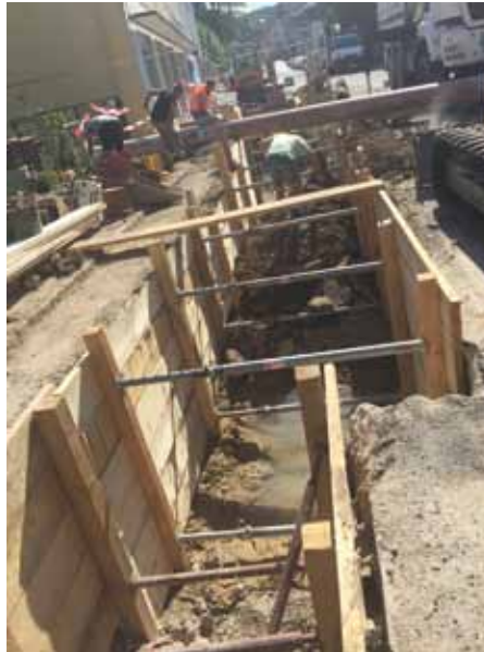
Die Großbaustelle beim Gießhüblerbach
